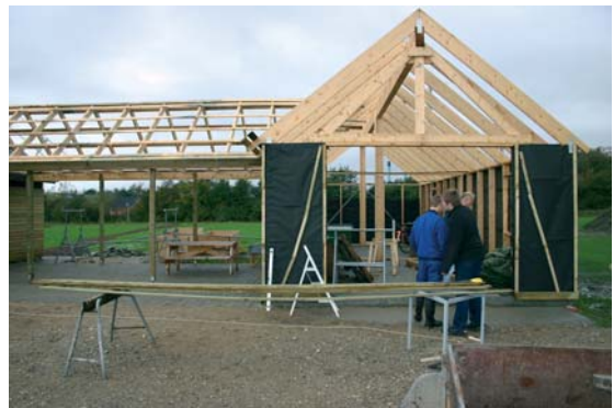
Bygninger tager form, der arbejdes på værkstedet.
